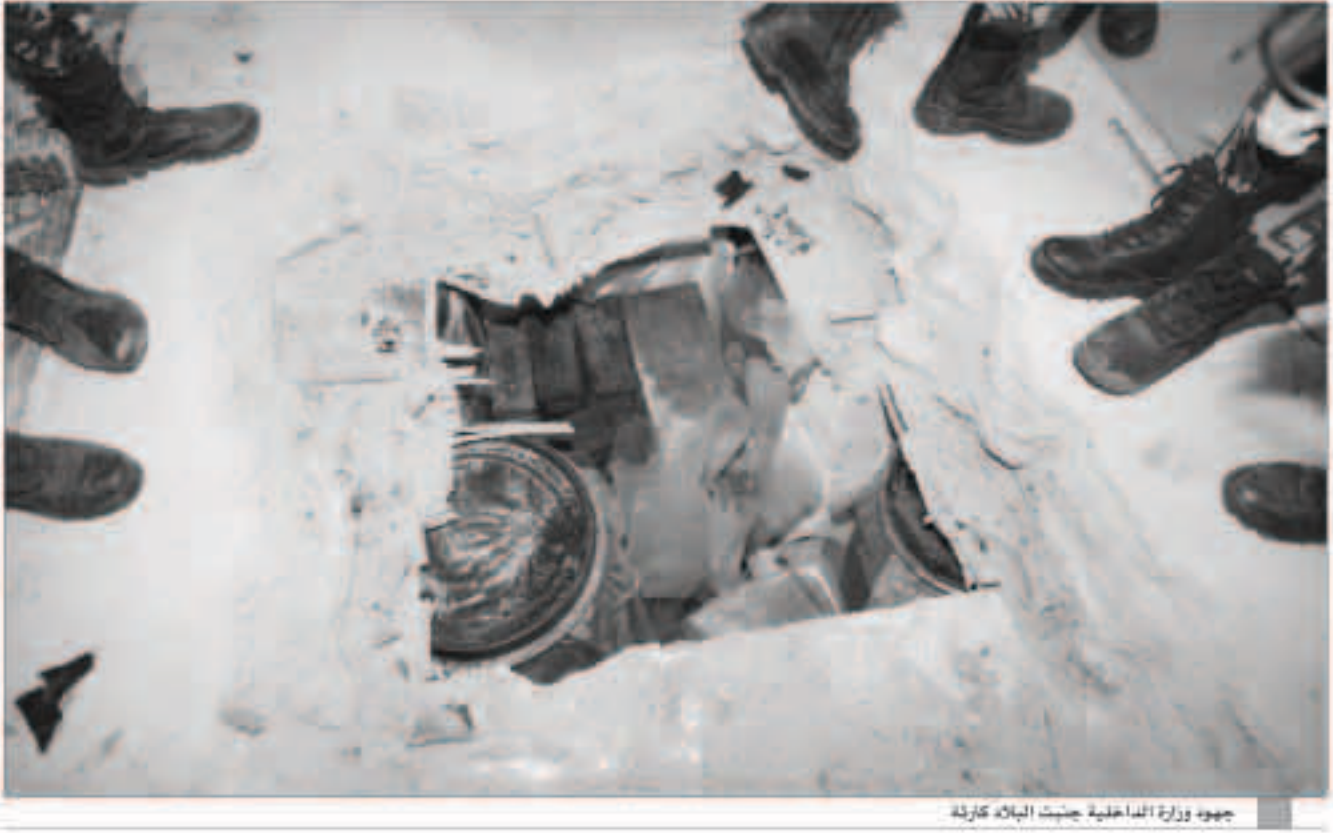
جبهة وزارة الداخلية حيث البلاد كارتة
