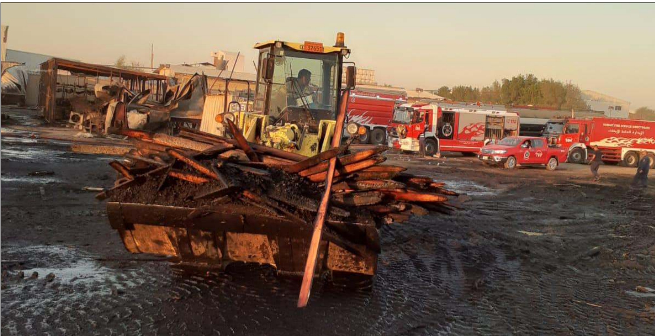
تنظيف بقايا الحريق
