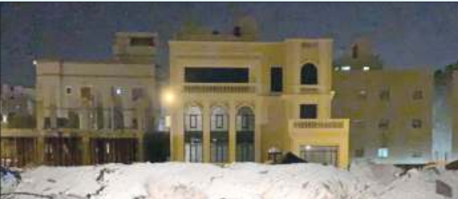
مخالفات البناء ترصدها عين البلدية
