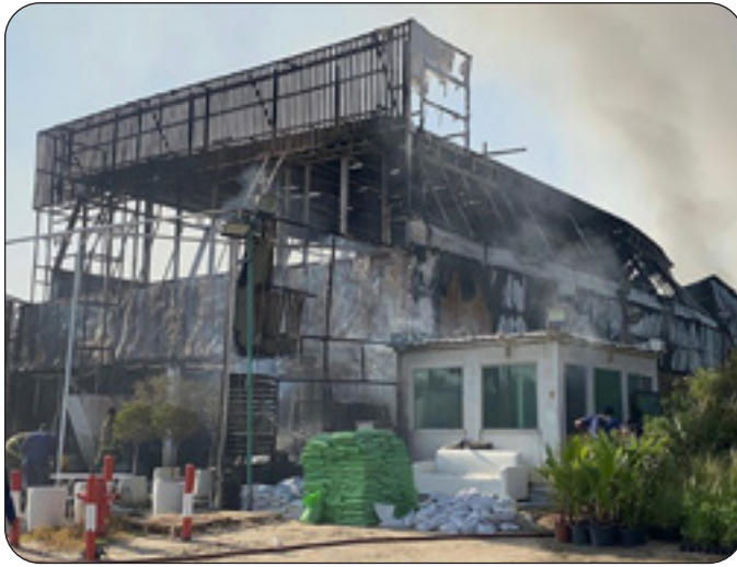
جانب من الحريق
