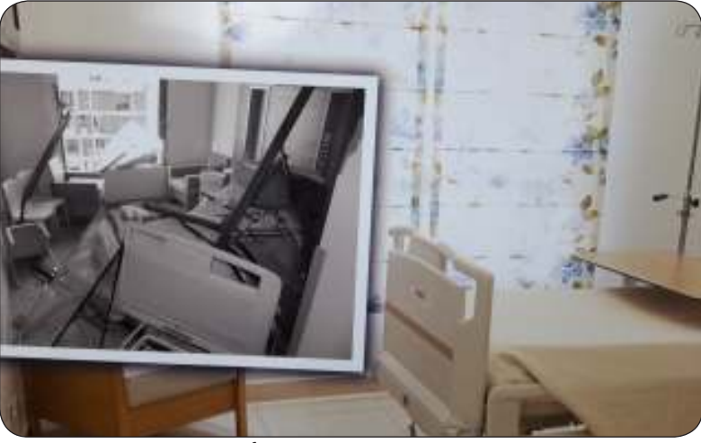
صورة تظهر حجم الأضرار وإتمام أعمال الترميم
