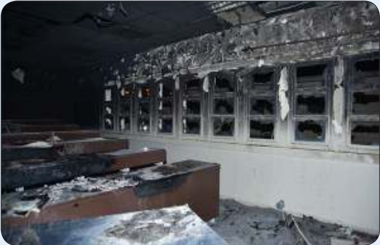
■ جانب من الحريق
