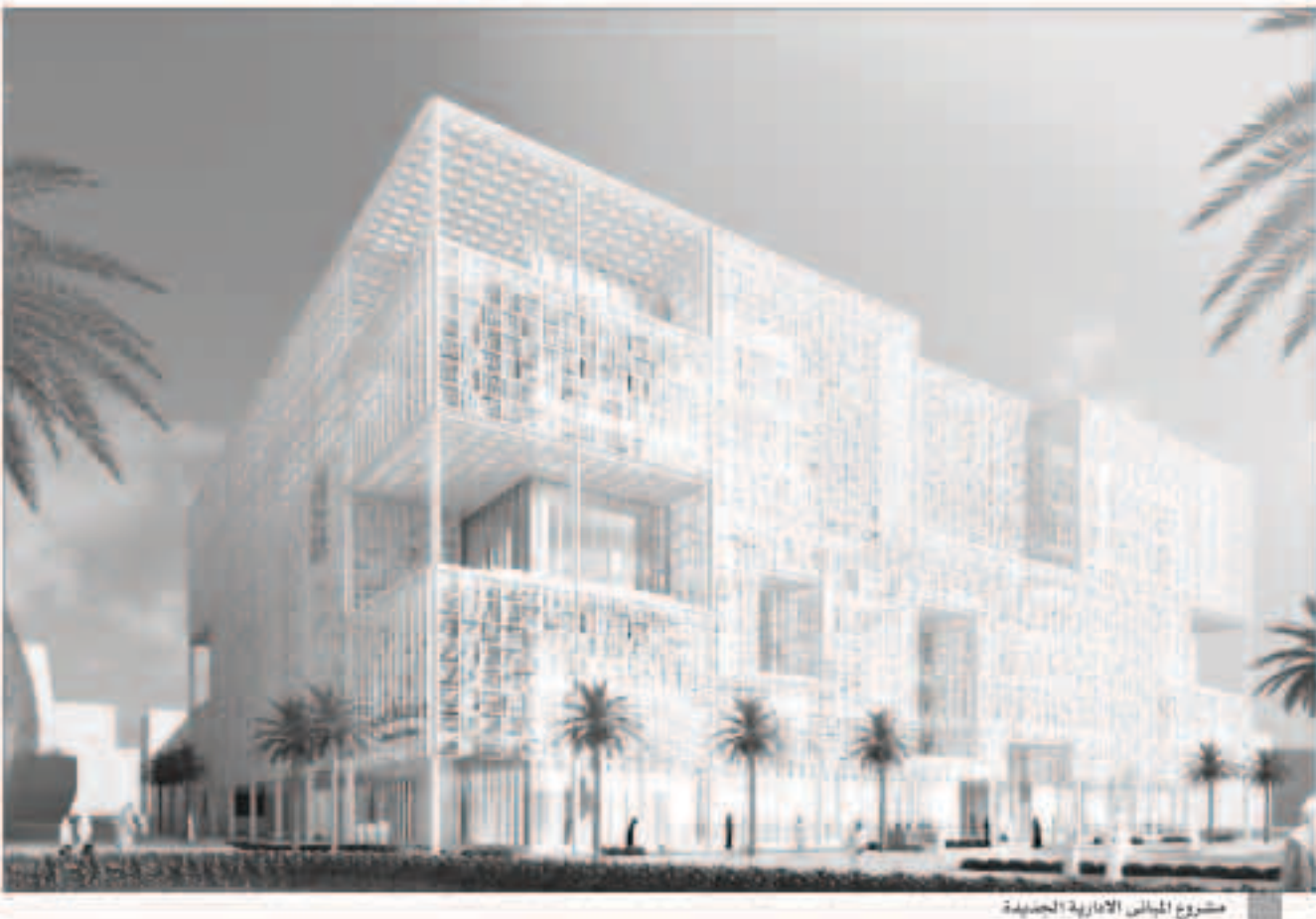
مشروع المباني الإدارية الجديدة
