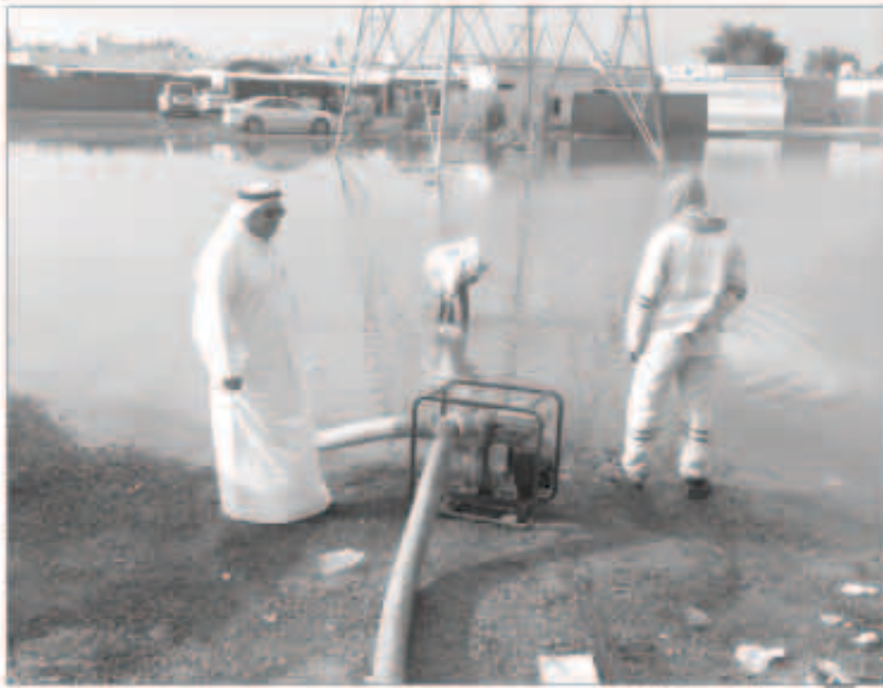
سحب المياه من بركة المياه
