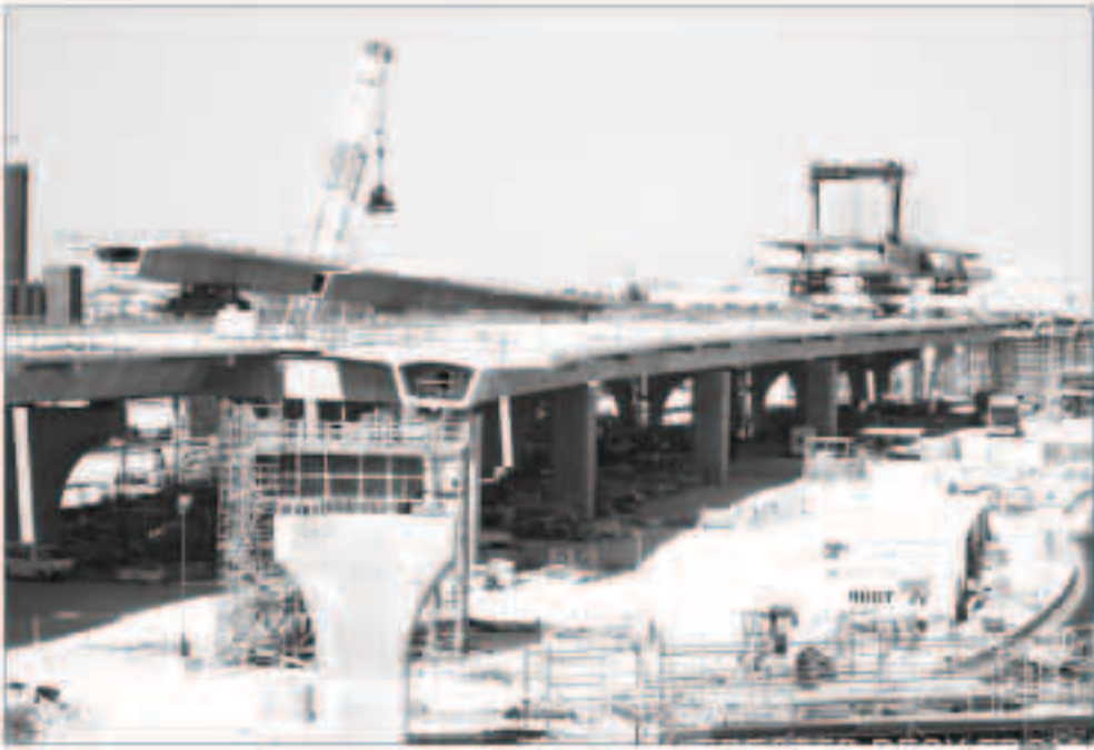
أعمال الانجاز في مشروع طريق جمال عبد الناصر تسير بسرعة كبيرة
