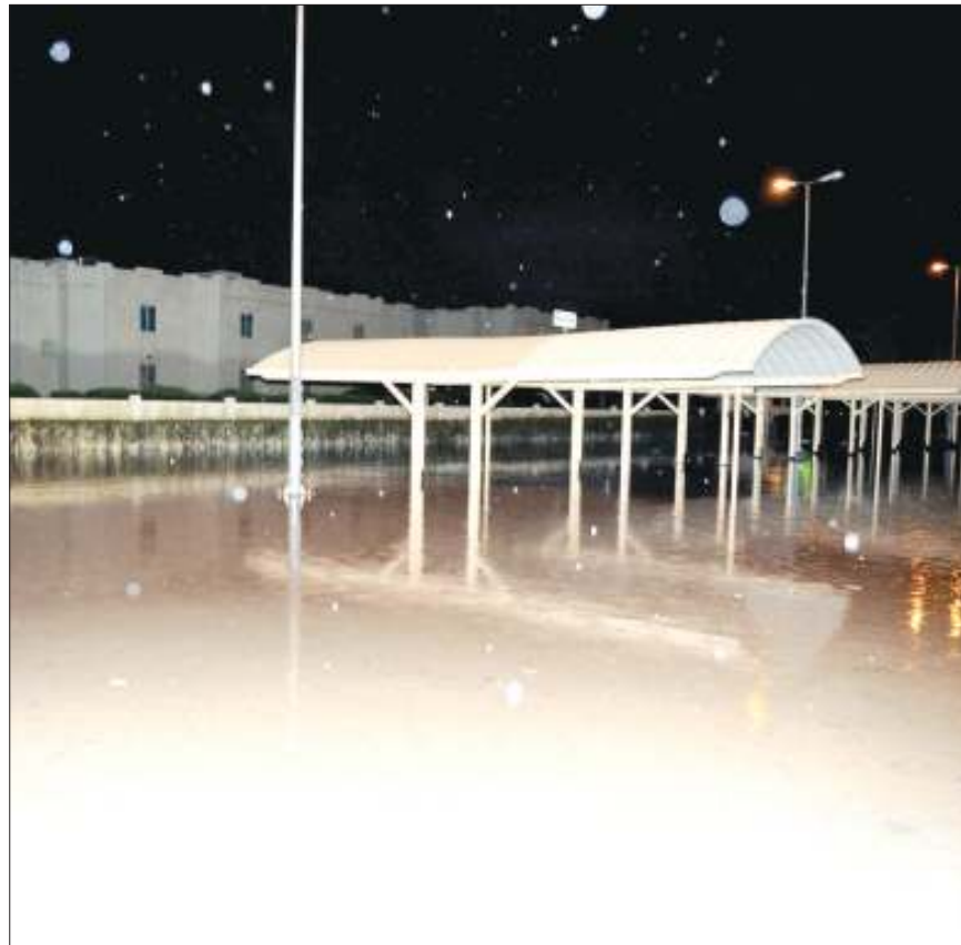
المياه ارتفعت فوق الأرض
