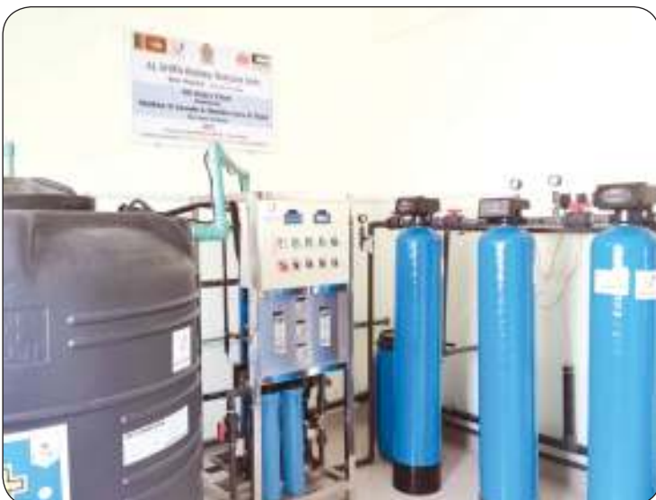
■ وحدة تنقية المياه التابعة لمركز الغسيل الكلوي
