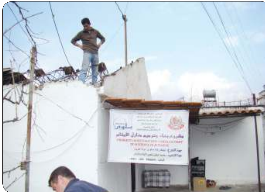
■ ترميم بيوت فقراء
