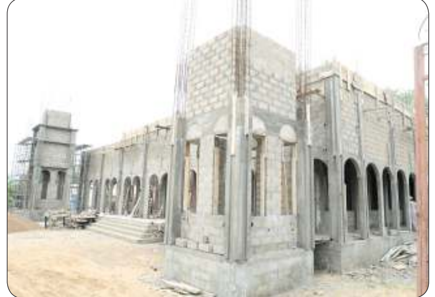
مسجد تحت التشييد
