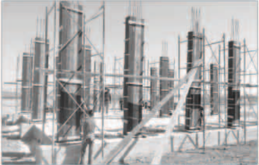
جانب من أعمال بناء المخيم
