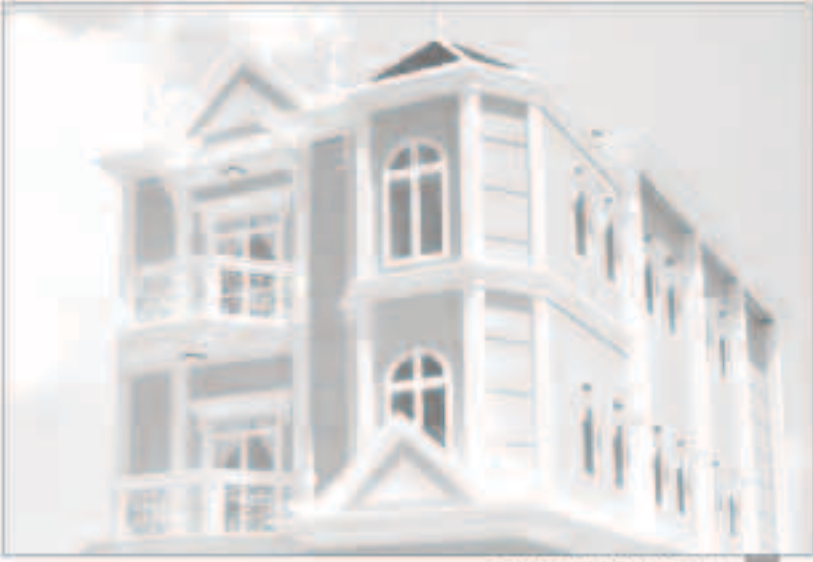
مبنى سكن الطالبات من الخارج
