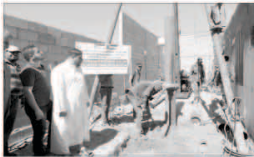
من أعمال الحفر
