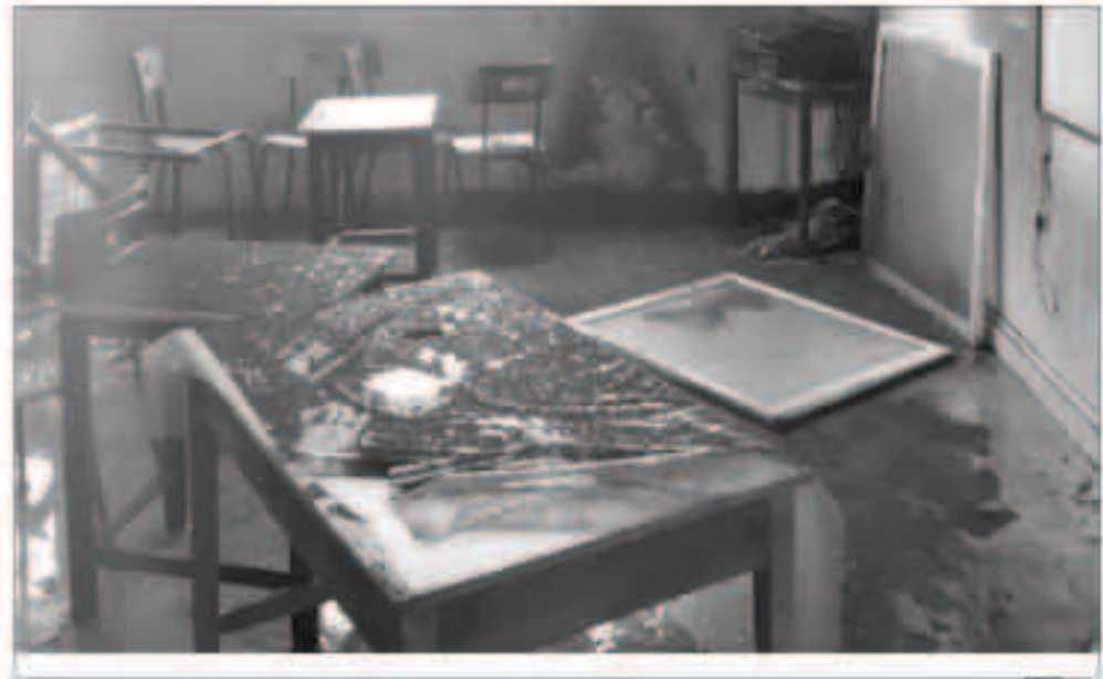
جانب من الحريق
