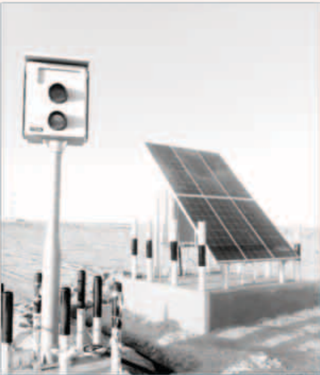
الألواح الشمسية لتزويد الكاميرات ضد السرعين بالطاقة
