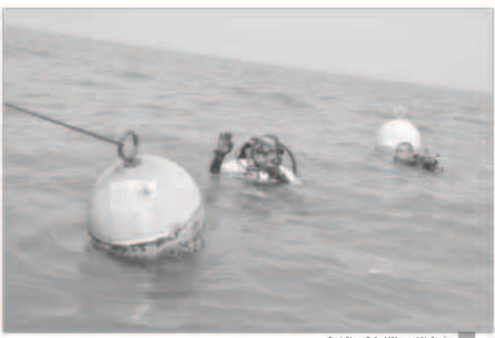
فريق الغوص أثناء تركيب المرباط
